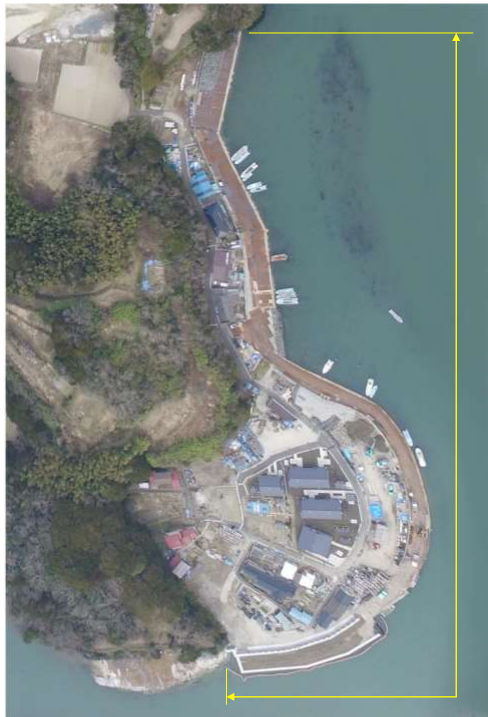
朴島の工事範囲 … 黄色矢印の区間
