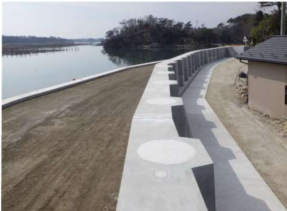
完成した防波堤、護岸
