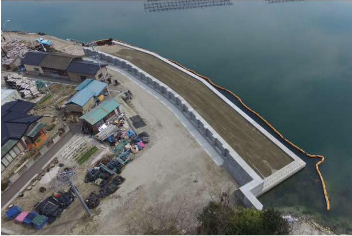
朴島の完成した防波堤、護岸
