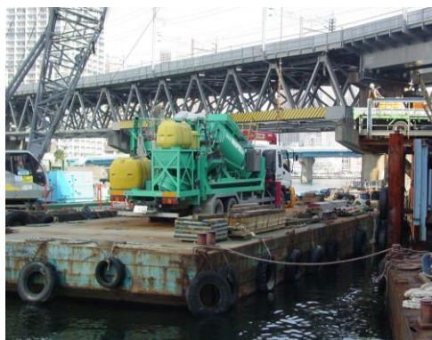
モノレール支柱補強工事中の スーパーMP21A 後ろにモノレールのレールとビル群が見えます
