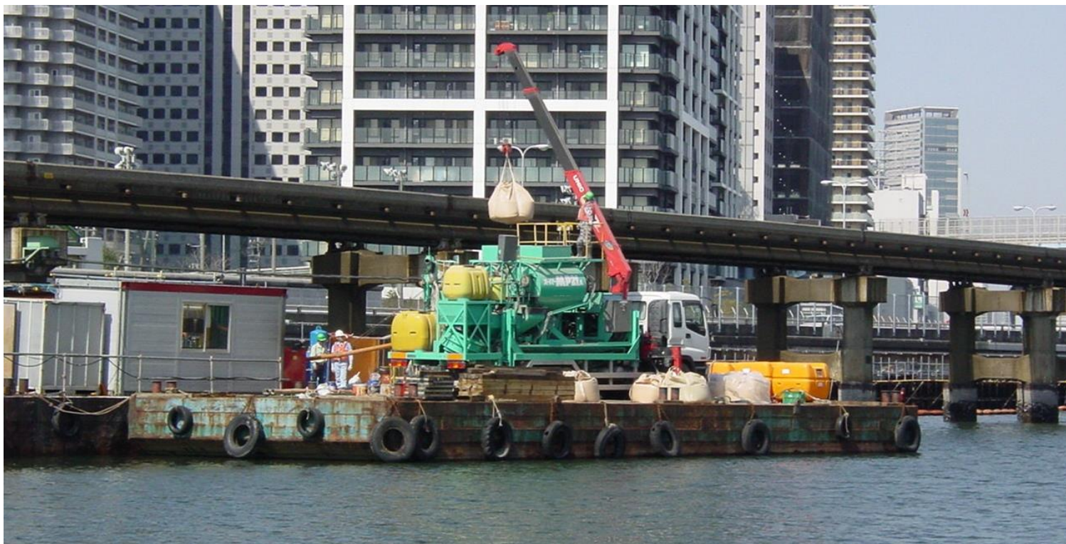
モノレール支柱補強工事中の スーパーMP21A 後ろにモノレールのレールとビル群が見えます
