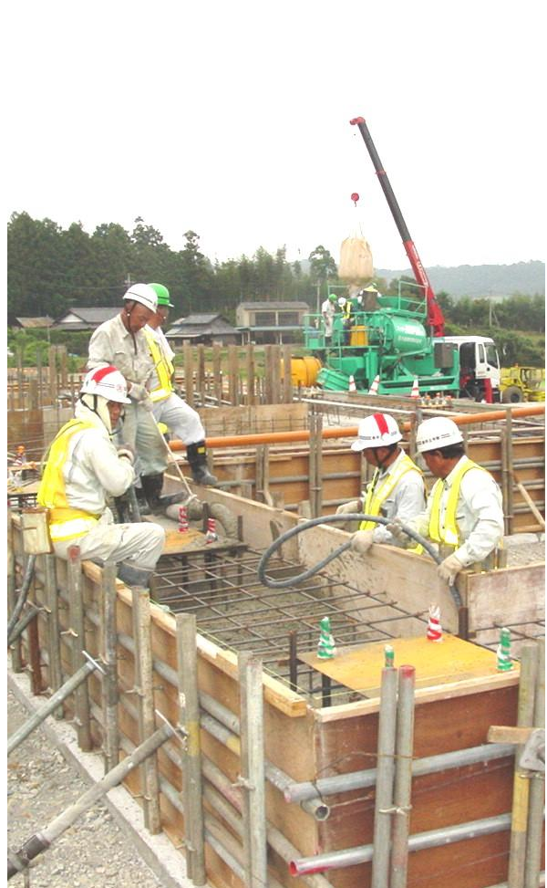
コンクリート打設中の様子
