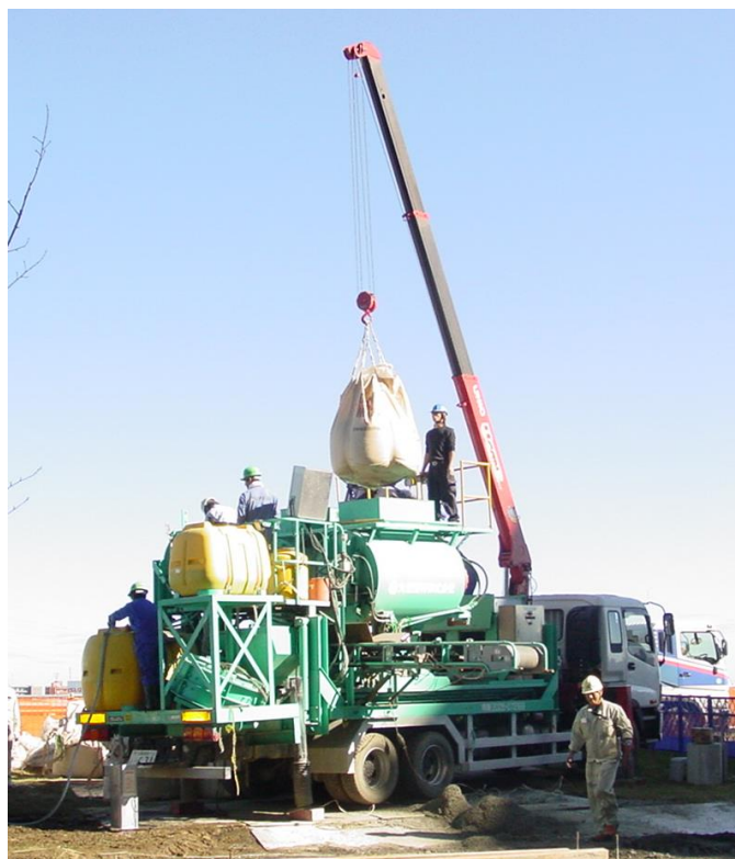
圧送ポンプで基礎工事中の スーパーMP21A
