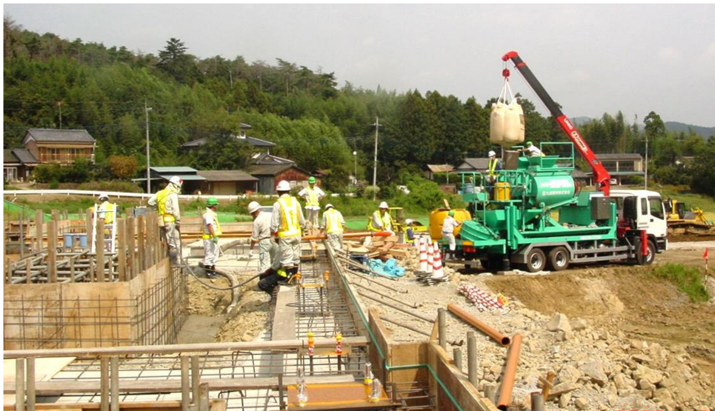
コンクリート打設中の様子
