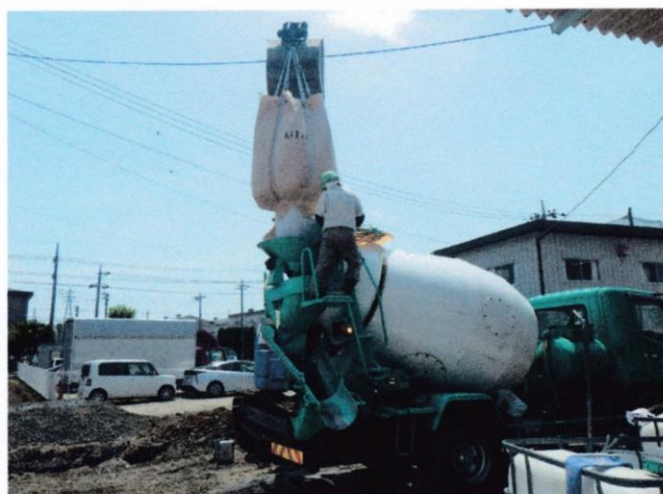
材料投入状況
