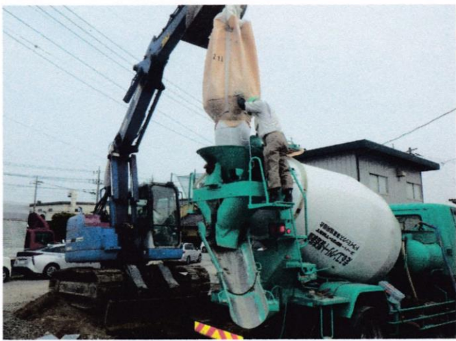
材料投入状況
