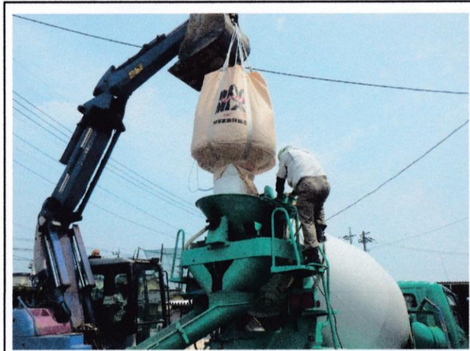
材料投入状況
