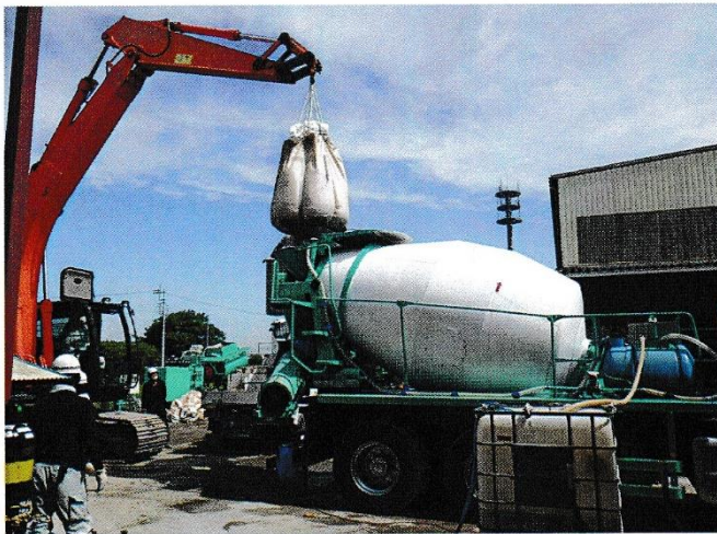
材料投入状況
