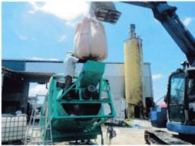
材料投入状況
