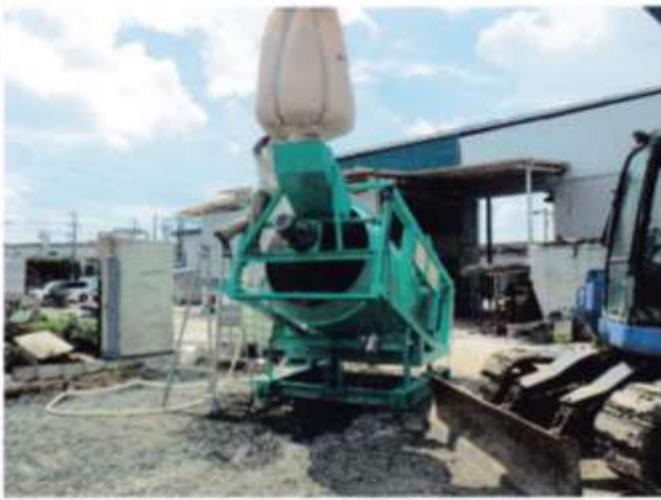
材料投入状況
