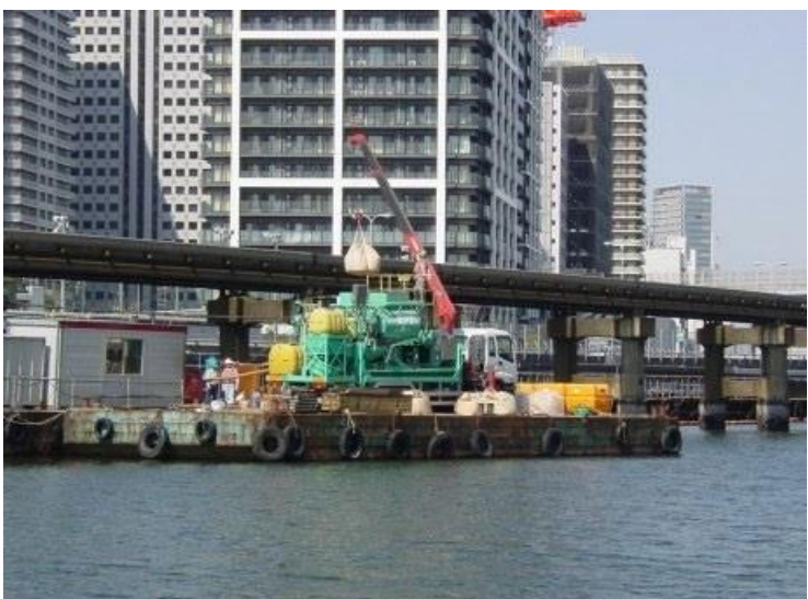
モノレール支柱補強工事 スーパーMP21A
