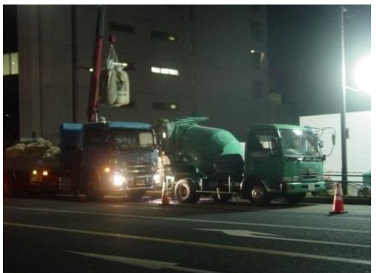
スーパーMP21-TM 夜間工事
