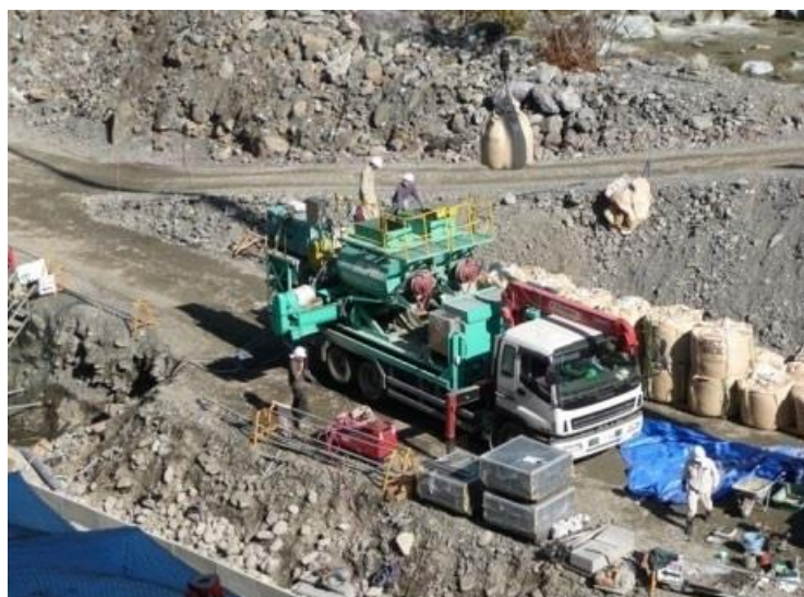
山梨県野呂川護岸工事 スーパーMP21A
