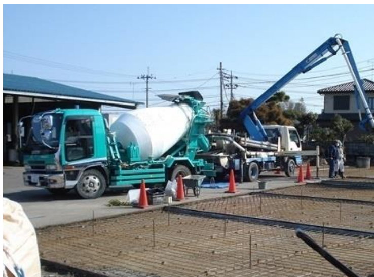
基礎工事(コンクリートポンプ車) スーパーMP21-TM8T3
