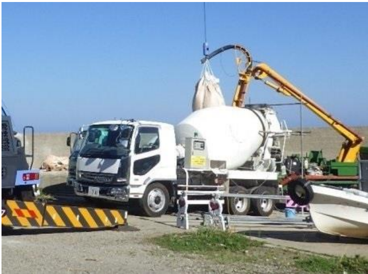
釜谷漁港東防波堤・船揚場機能保全工事 スーパーMP21-TM10T2
