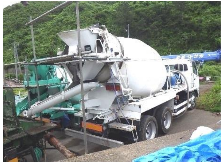
釜谷漁港東防波堤・船揚場機能保全工事 スーパーMP21-TM4 スーパーMP21-TM10T2(手前)
