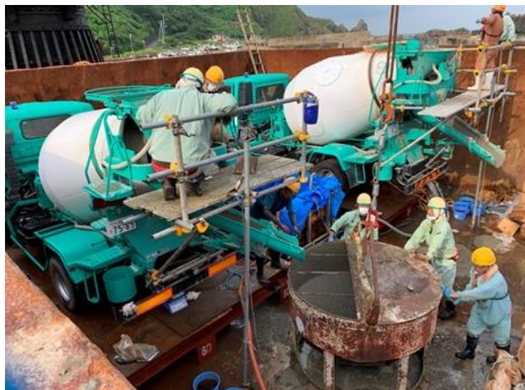
釜谷漁港東防波堤・船揚場機能保全工事 (台船でのコンクリート製造) スーパーMP21-TM3 (手前) スーパーMP21-TM8T
