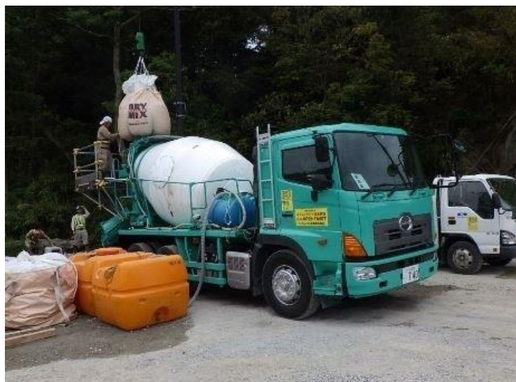
野々島地区海岸災害復旧工事 スーパーMP21-TM10T
