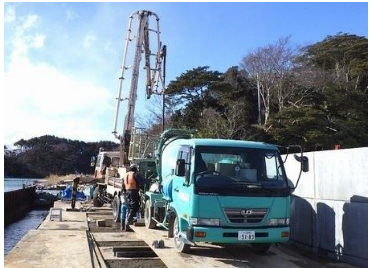
宮城県朴島地先海岸（南側）災害復旧工事 スーパーMP21-TM
