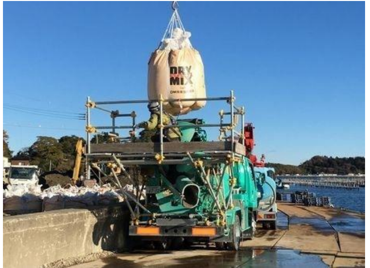
宮城県朴島海岸（南側）災害復旧工事 スーパーMP21-TM2
