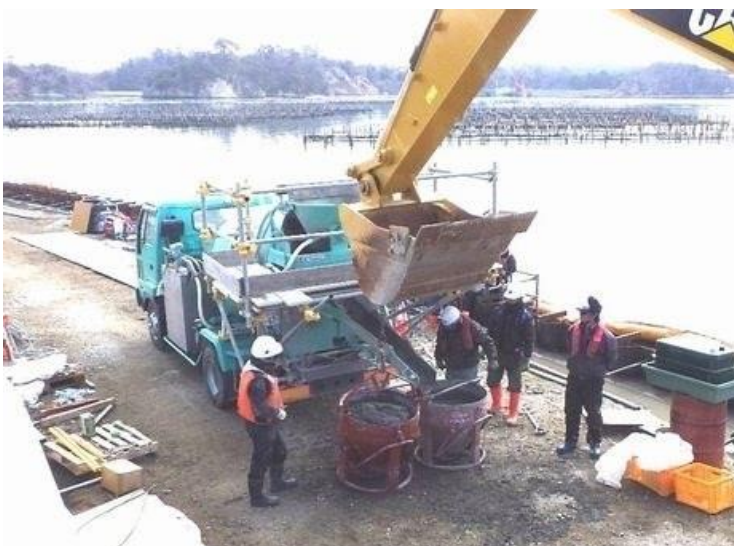
宮城県朴島地先海岸（南側）災害復旧工事 スーパーMP21-TM2
