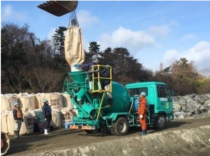
宮城県朴島海岸（東側）災害復旧工事 スーパーMP21-TM
