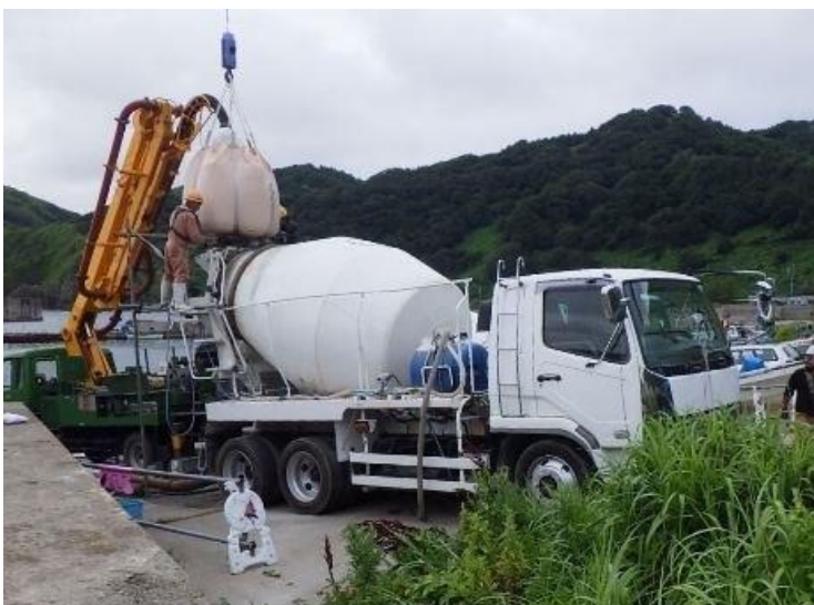
釜谷漁港防波堤船揚場機能保全工事 スーパーMP21-TM10T2
