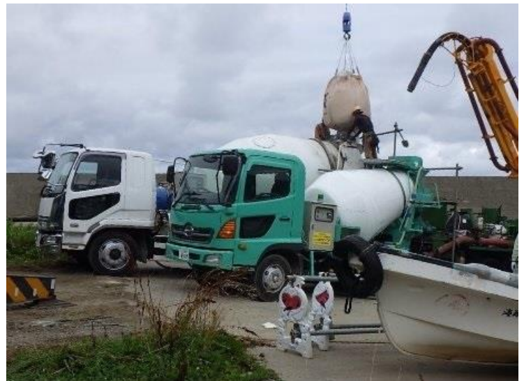
釜谷漁港東防波堤・船揚場機能保全工事 スーパーMP21-TM10T2 スーパーMP21-TM4 (手前)
