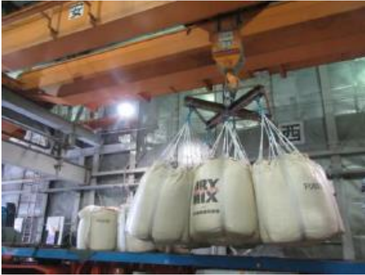
トンネルの吹付に使用されたドライミックス
