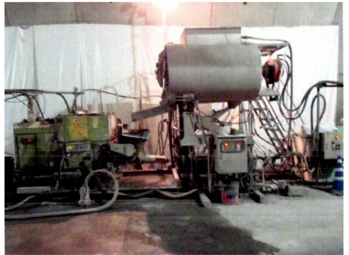
コンクリートを製造中のスーパーMP21A2
