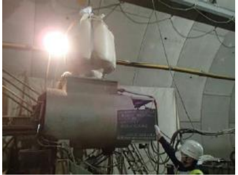
トンネル現場で吹き付け用コンクリートを製造中の スーパーMP21A2
