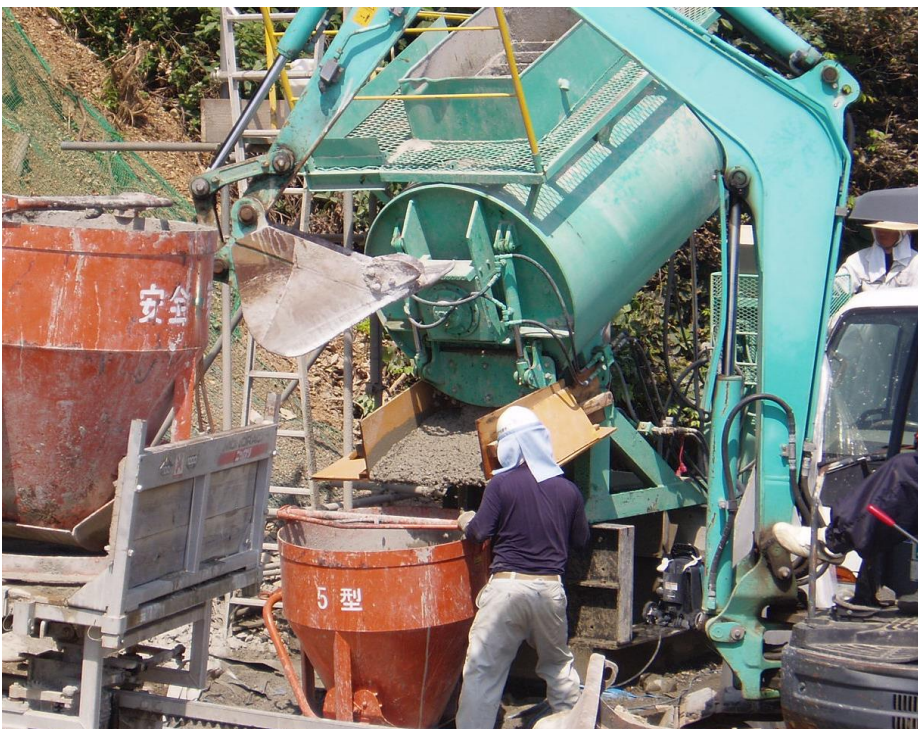
コンクリートを排出中のスーパーMP21A1
