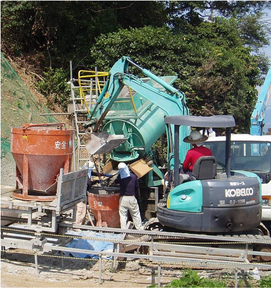
コンクリート製造中のスーパーMP21A1
