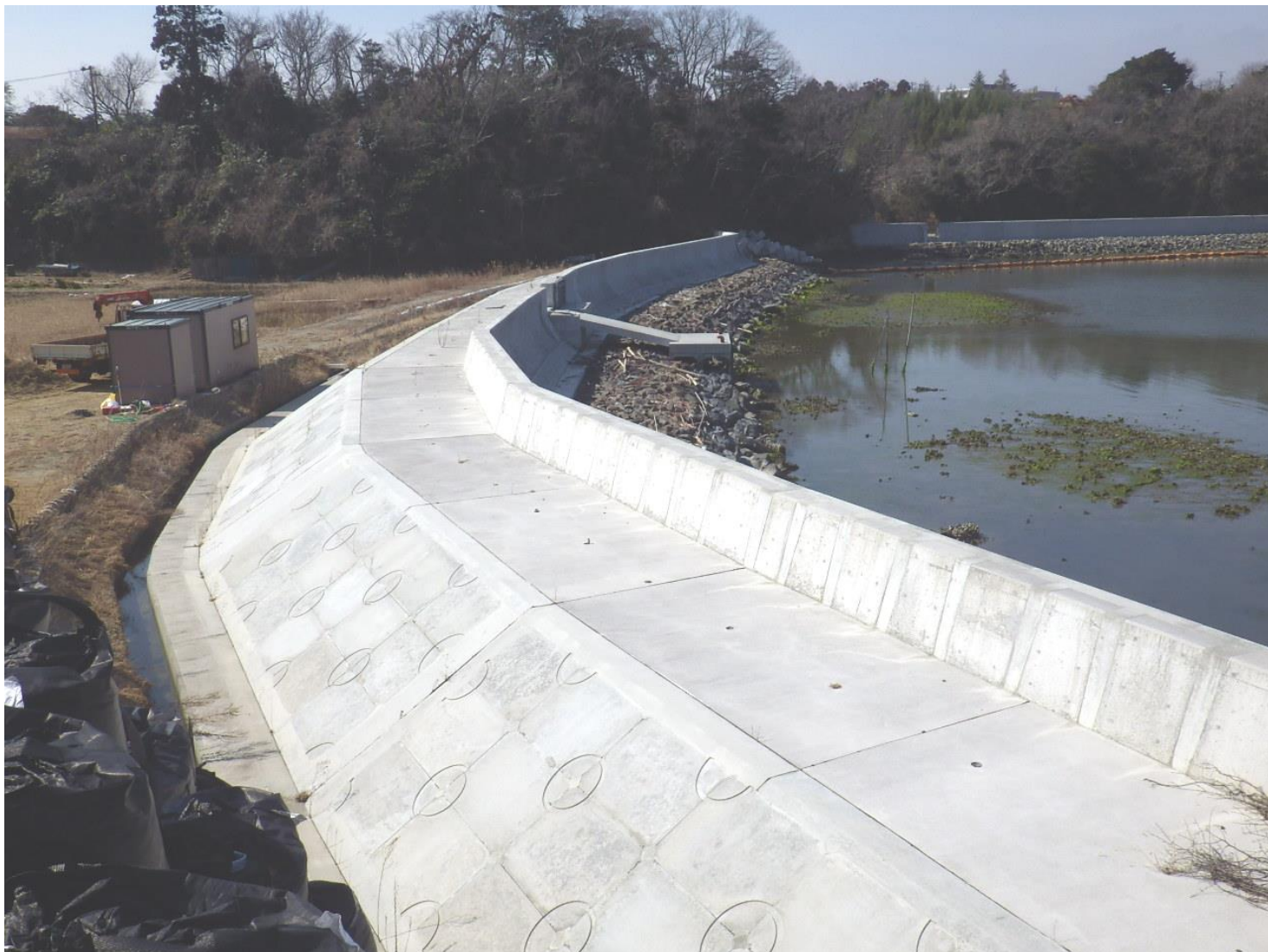
完成した防潮堤
