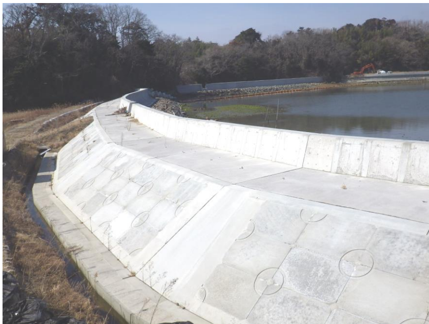
完成した防潮堤
