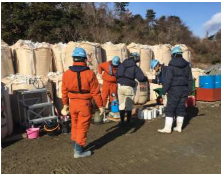
DM 置場前でコンクリート試験実施中
