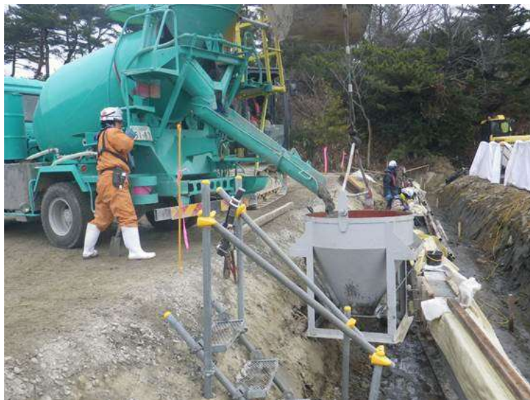
コンクリート排出中の スーパーMP21-TM
