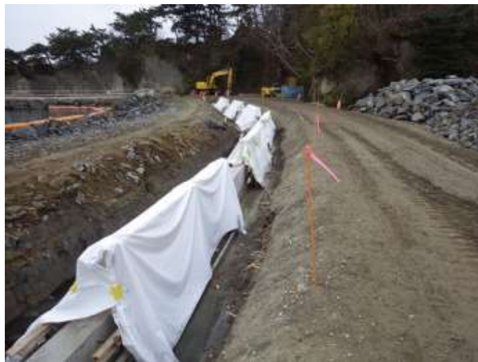
コンクリート養生中
