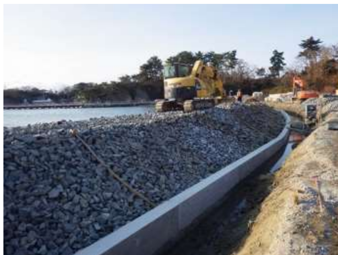
防潮堤基礎コンクリート
