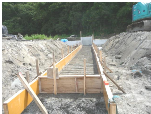
災害地復旧工事
