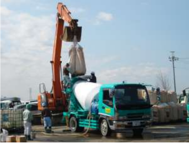
ドライミック練り混ぜ状況 ミキサ；スーパーMP21-TM-8T
