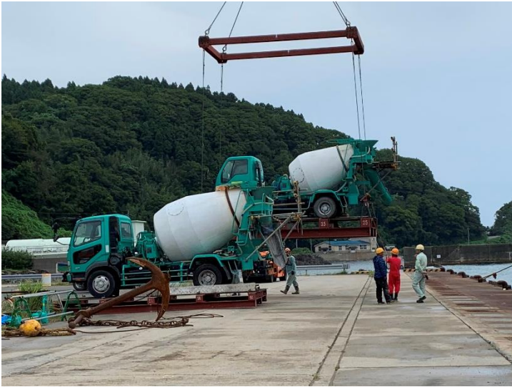
台船に載せるために吊り上げられたコンクリート製造装置
