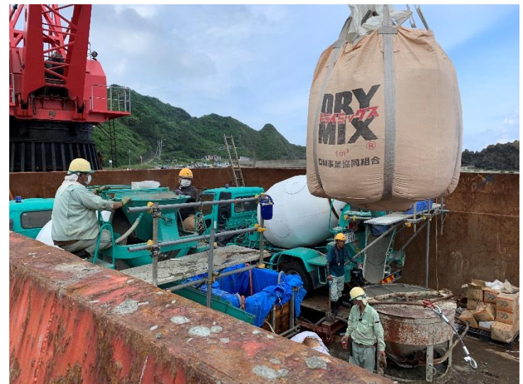
水中不分離性混和剤エルコン(太平洋マテリアル製)使用
